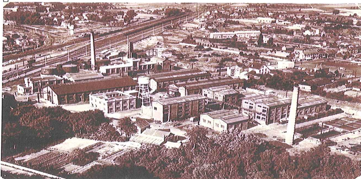
Usine de distillation de goudron et de mélanges carbochimiques en 1955
